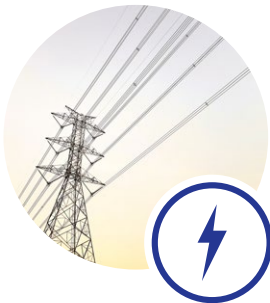
スマート・エネルギー (ソーラー・パネル、 ガス・パイプライン、送電網など)
